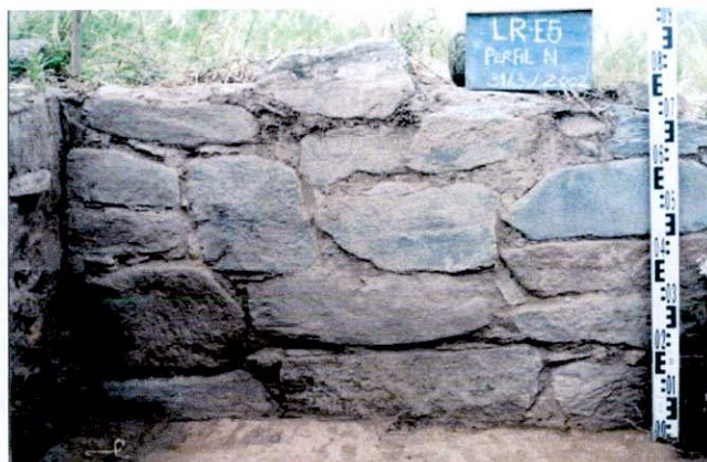
Figura 6.4: Muro norte de la Estructura 5.
