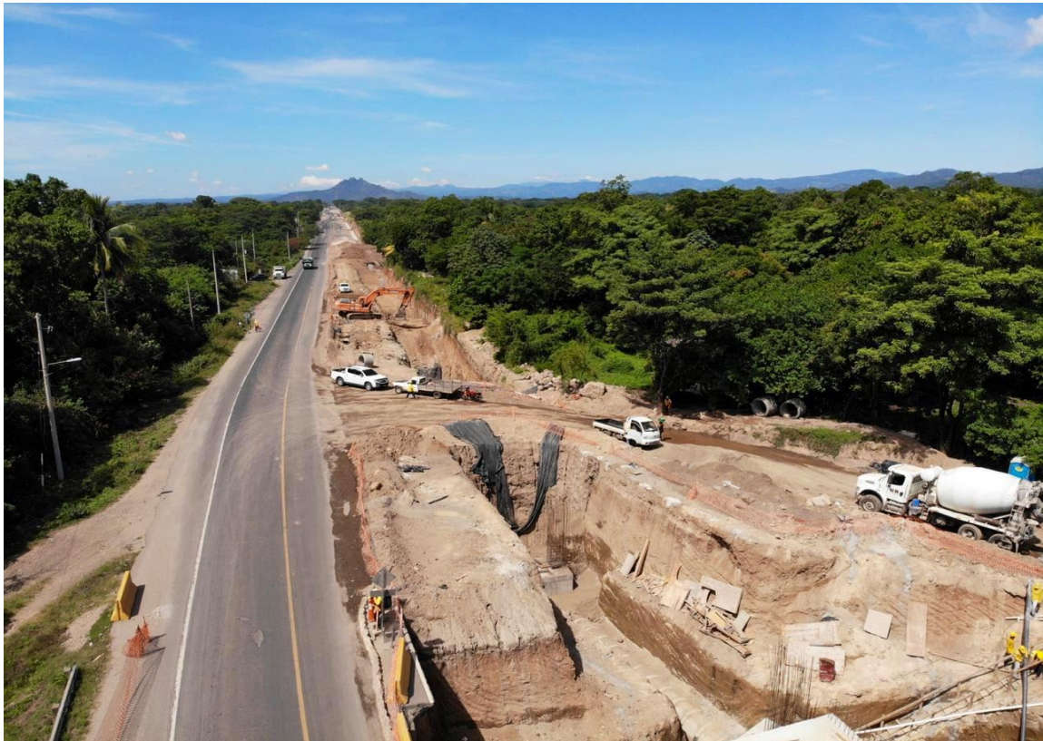
Figura 11. Tramo de la Carretera Litoral intervenido por FOMILENIOII
