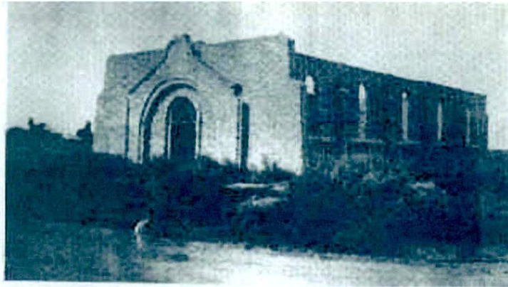
Iglesia en Construcción "Cristo Redentor".
