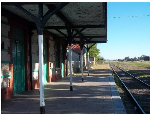
FIGURA 17: ESTACIÓN DE TREN DE SILDUNGARAY (2018) – PROPIA AUTORÍA
