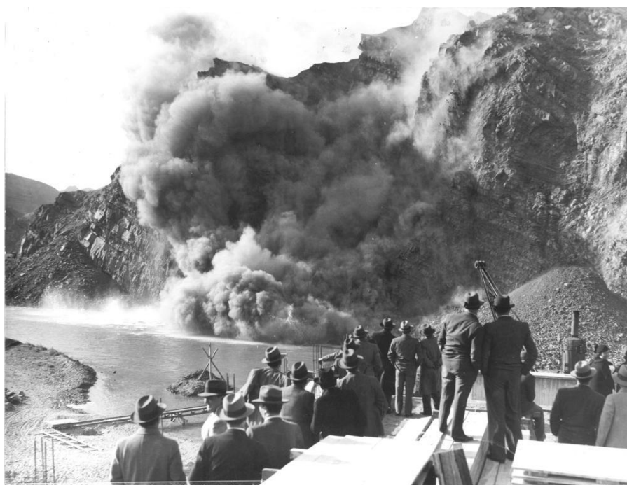
Figura 4. Construcción del camino a Ullum. Fuente: Juan Carlos Bataller (1997), foto Lucrecia Devoto de Godoy.
