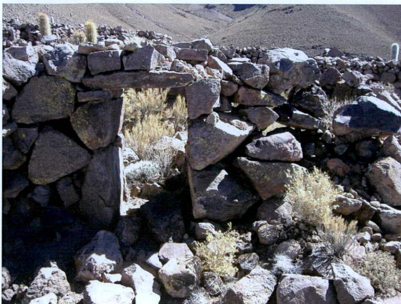
Figura 8.15. Vano del Recinto 4 Unidad Arquitectónica 7 desde el Sur.
