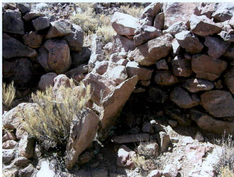
Figura 8.16. Deflector del Recinto 2 de la Unidad Arquitectónica 17.
