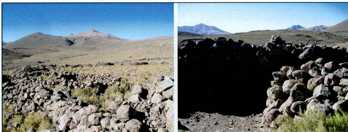
Figura 4.8. Fotografías de Chimas Pata. A la izquierda, vemos la muralla que divide los dos sectores, y de fondo se aprecian las estructuras rectangulares. A la derecha, un detalle de la muralla con las troneras de observación.
