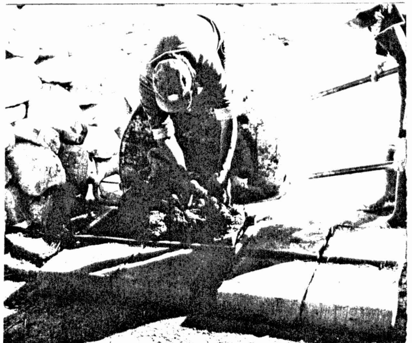
Dos momentos en la elaboración de los adobes : arriba cortando la paja que se mezclará con el barro, abajo colocando la mezcla en la adobera
