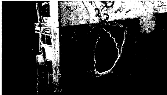
Imagen N° 13: Fotografía, agujero de una pared de la escuela cercana al barrio (E1)
