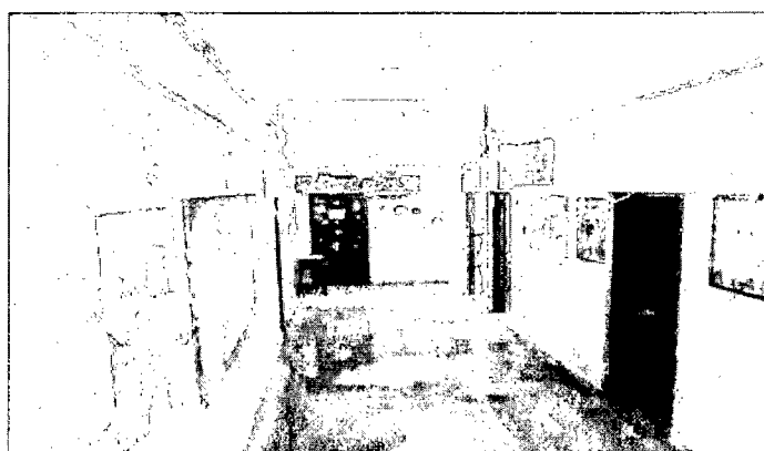
Imagen N°7: Pasillos de la escuela inundada, 2016.
