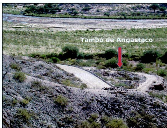
Figura VI. 12. Vista desde la muralla del Pukará al Tambo de Angastaco. Obsérvese el grado de deterioro y alteración por la ruta, el camino y las tierras de cultivo (Gentileza Paula Villegas).
