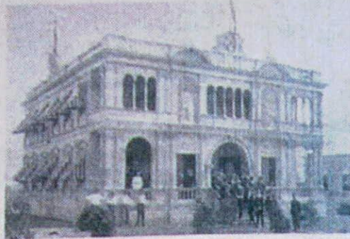
VISTA EXTERIOR DEL PABELLÓN ARGENTINO
