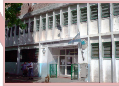
Fachada de la Escuela (Registro fotográfico propio)
