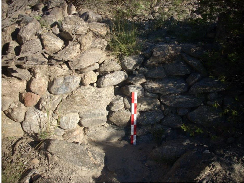
Figura 8.4 Detalle de muro interno del R1 de la UA 11.
