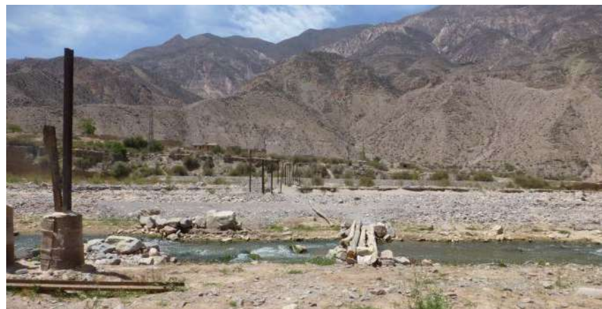
Gráfico 73|C6. Cruce del río Grande para acceder a la urbanización polar , comunidad Coquena., pasarela en desuso a medio hacer. Fotografías propias, 2014.
