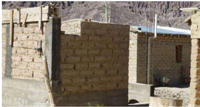
Gráfico 59|C6. Urbanización polar , comunidad Chalala. Sobrecimientos* de hormigón armado*, con columnas* y vigas* del mismo material. Techo con membrana asfáltica aluminizada. Fuentes: fotografías propias, 2014.
