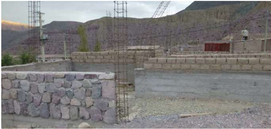
Gráfico 55|C6. Urbanización polar , comunidad Chalala. La iglesia en Chalala, en etapa de construcción. Fuente: fotografía propia, 2014
