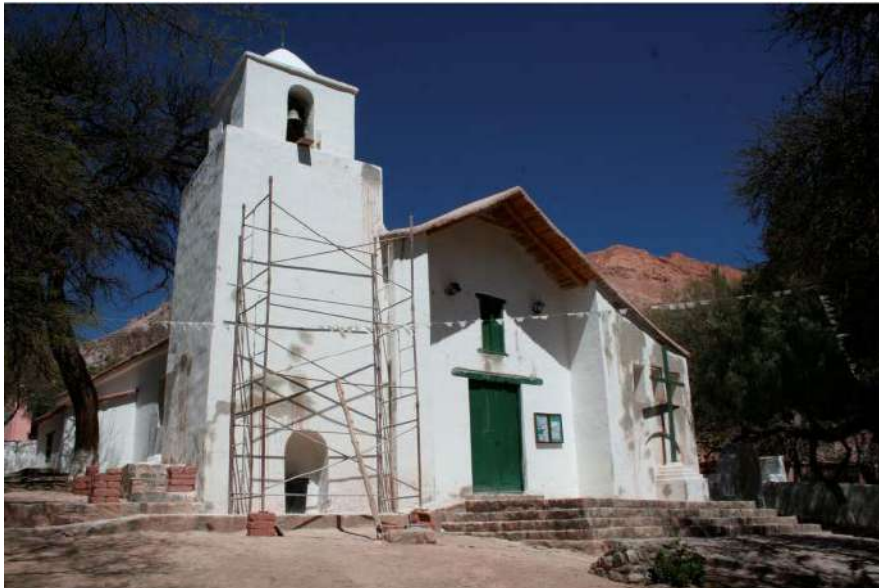
Capilla de Purmamarca en etapa de restauración
