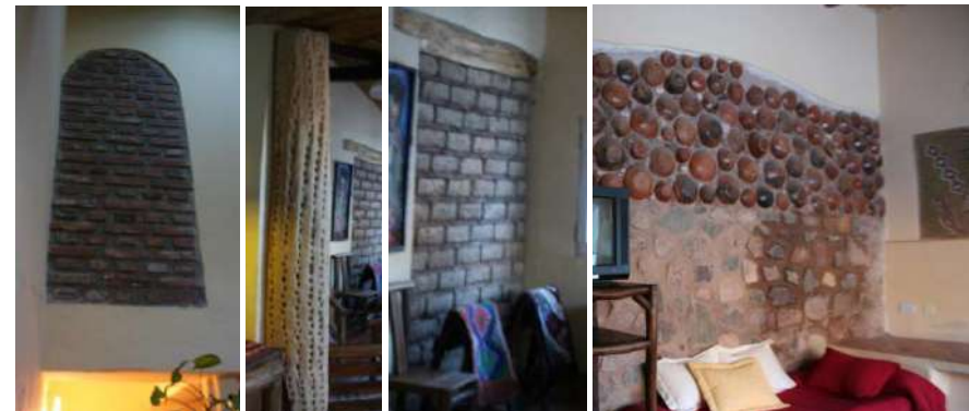
Ladrillo visto Cardón Adobes* a la vista Ollas en el muro y piedras a la vista
