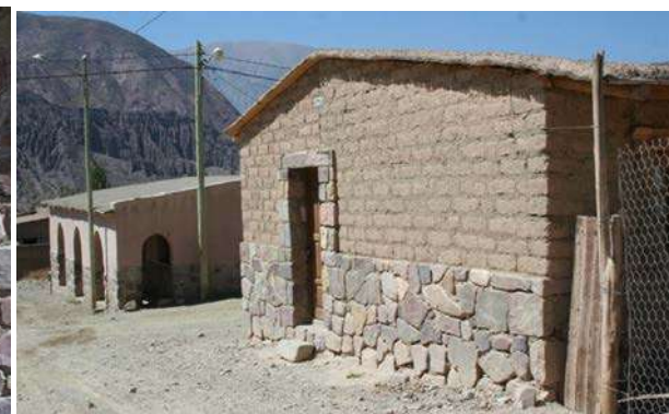
Gráfico 63|C6. Urbanización polar , comunidad Chalala. Fachada* con detalle de piedra alrededor de la puerta. Fuente: fotografía propia, 2011.
