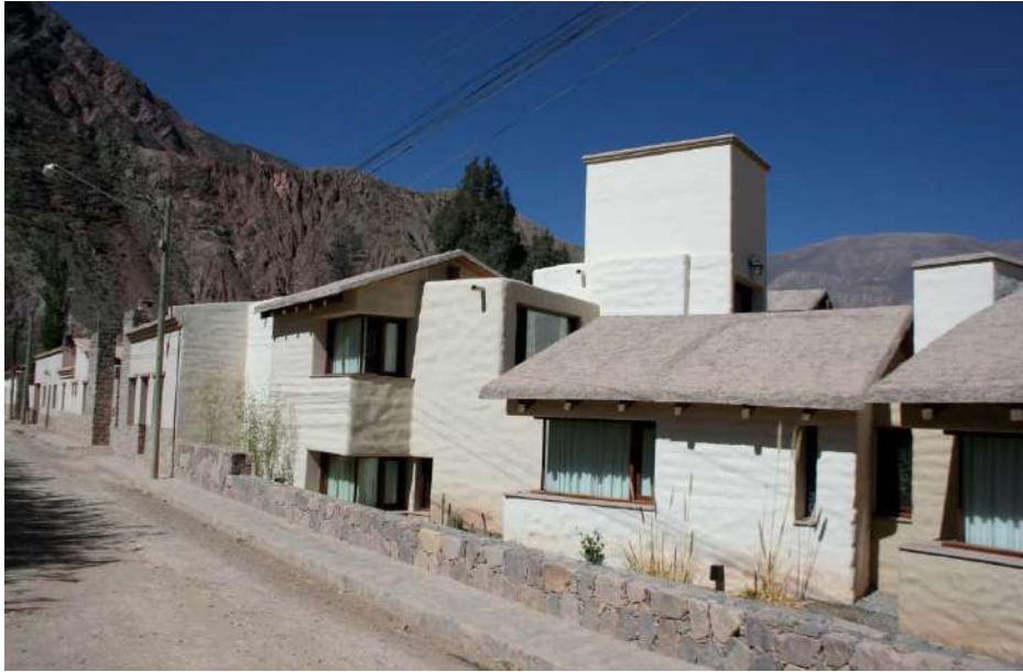
Pisos semienterrados y dobles alturas
