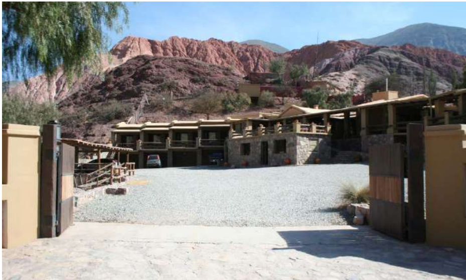
Terrazas y balcones
