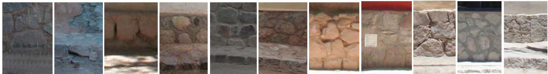
Gráfico 19|C5. Muestreo del conglomerado urbano de Purmamarca. Variedad de sobrecimientos*, veredas y terminación en el encuentro pared y piso –sin sobrecimiento o con revoques* de piedras simulando un sobrecimiento-, en viviendas nuevas. Fuentes: fotografías propias, 2011.
