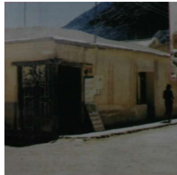
Gráfico 28|C3. Fotografía de una de las viviendas que forma parte del recuadro de la Postal Urbana , el epígrafe de la fotografía dice: "Puerta doble en Purmamarca" Fuente: reproducido de Albeck et al. (1999:86).
