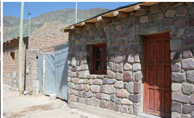
Gráfico 62|C6. Urbanización polar , comunidad Chalala. Fachada* completamente de piedra y con nylon en su cubierta. Fuente: fotografía propia, 2011.
