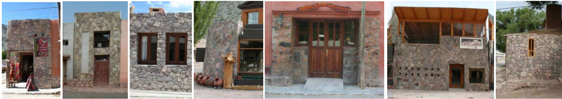
Gráfico 46|C5. Muestreo del conglomerado urbano de Purmamarca. Sectores de cerramientos* verticales completamente de piedras. Fuentas: fotografías propias, 2011.
