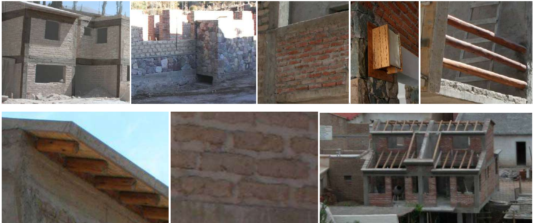
Gráfico 43|C6. Purmamarca. Materiales en nuevos alojamientos. Estructura* de hormigón armado* independiente, piedras como terminación en detalles estéticos, adobes* y ladrillos comunes*, detalles estéticos realizados en madera, losas* inclinadas en el techo, etc. Fuente: fotografías propias, 2009, 2011 y 2014.
