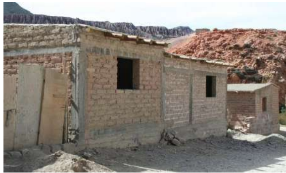
Gráfico 59|C6. Urbanización polar , comunidad Chalala. Sobrecimientos* de hormigón armado*, con columnas* y vigas* del mismo material. Techo con membrana asfáltica aluminizada. Fuentes: fotografías propias, 2014.
