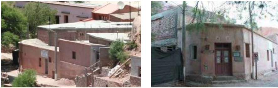
Gráfico 33|C5. (continuación) Muestreo del conglomerado urbano de Purmamarca. Última etapa de construcción de la vivienda que se amplió, se convirtió en alojamiento y se subdividió. Fuente: fotografías propias, 2012.
