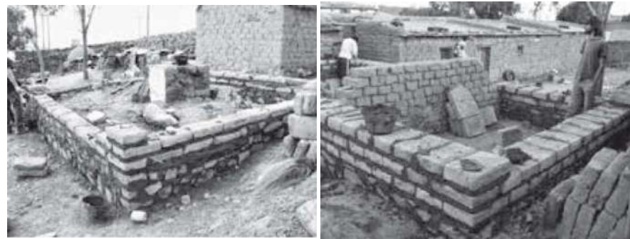
Gráfico 27|C4. Fotografías de muros de adobe. Incluyen los epígrafes: (izquierda) “Elevación de muro sogá, Rinconada, enero 2007. (Foto M. Rojas)” (derecha) “Elevación de muro doble*, Rinconada, enero 2007. (Foto C. Tommei)”. Fuente: reproducido de Rivet y Tomasi (2011:80).
