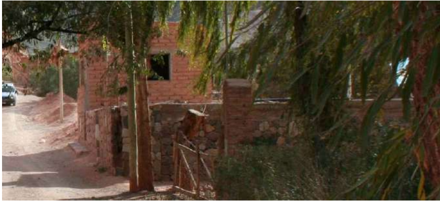
Gráfico 17|C6. Purmamarca, zona de protección del paisaje. Vivienda compacta de piedra semienterrada, al costado del Paseo de los Colorados. Fuente: fotografía propia, 2011.
