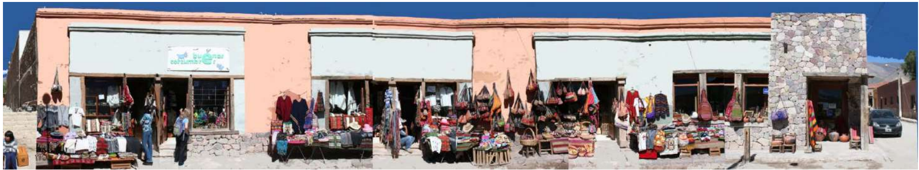
Gráfico 52|C5. Muestreo del conglomerado urbano de Purmamarca. Calle escaparate, edificio construido con el fin de albergar varios locales para turistas. Fuente: fotomontaje, elaboración propia, en base a fotografías propias, 2011.
