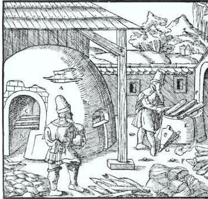
Figura 6.2: A) Horno similar a un horno de cocción empleado para la copelación. B) Pasaje. C) Barras de hierro. D) Orificio a través del cual el litargio es sacado del horno. E) Crisol que carece de bóveda. F) Palos gruesos. G) Fuelles. (Agricola [1556] 1950: 482).
