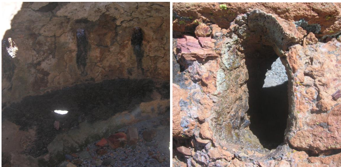
Figuras 4.33 y 4.34: Interior de la bóveda donde se observa el piso y parte de las paredes vitrificadas en el sector de los orificios de respiración (izq.). Detalle de uno de los orificios de respiración de la bóveda desde el exterior (der.).
