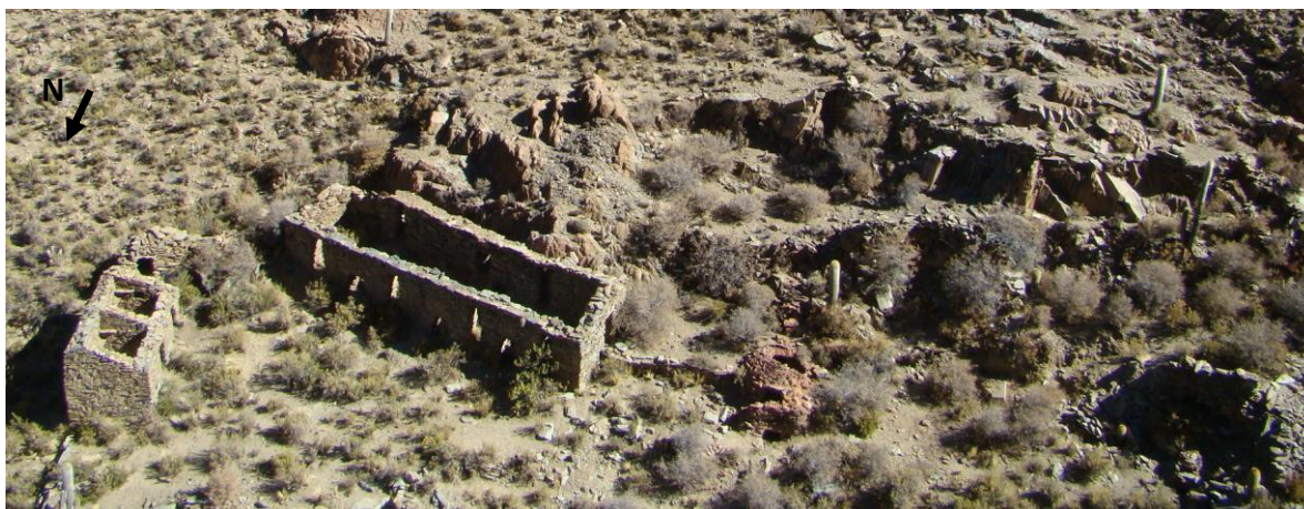
Figura 4.36: Vista general de la instalación Fundiciones 2.
