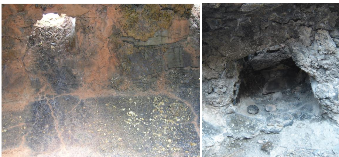
Figuras 4.57 y 4.58: Detalle de la pared interna de la bóveda, de la vitrificación alrededor de uno de los orificios de respiración y en el suelo (izq.). Vista de la abertura que conduce a la chimenea desde la bóveda (der.).
