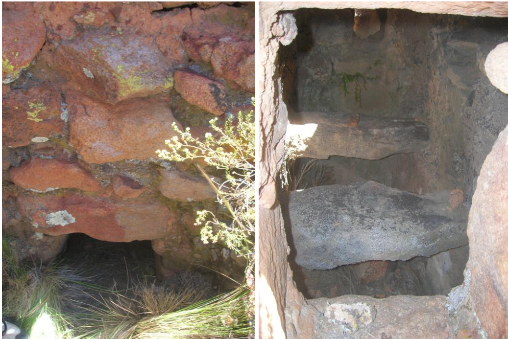
Figuras 4.29 y 4.30: Vista de la entrada frontal de la caja de fuego (izq.) y del interior de la misma, donde se observa la parrilla formada por dos rocas planas (der.).
