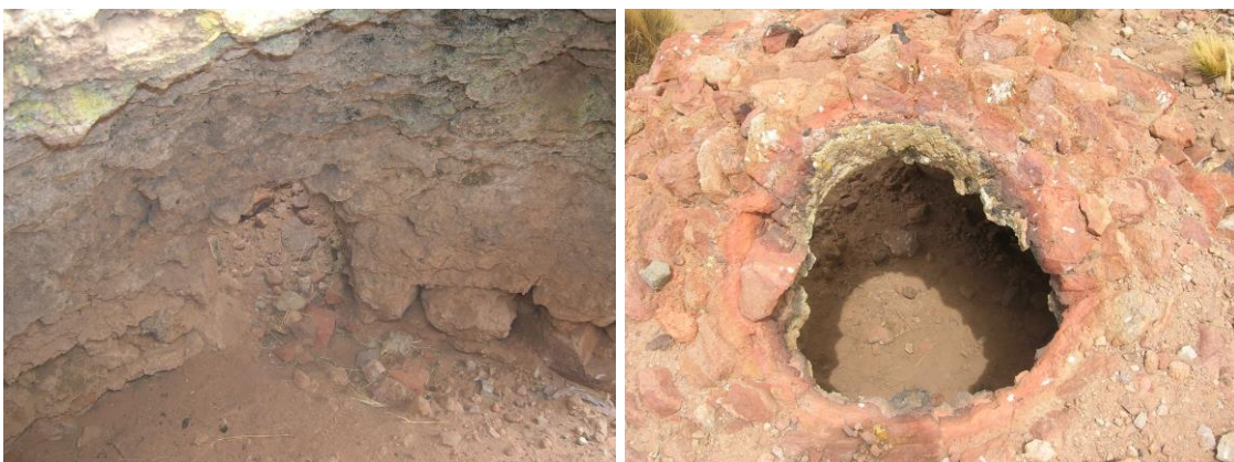
Figuras 4.13 y 4.14: Vista del interior de la bóveda, donde se observa la entrada al segundo conducto rectangular cuyo final no se distingue (izq.). Vista del orificio circular central de la bóveda donde se observa un vitrificado blanquecino (der.).
