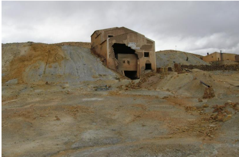
Figura 3.8: Vista de las instalaciones de la compañía Río Cincel SAMIC, en el yacimiento de Pan de Azúcar.
