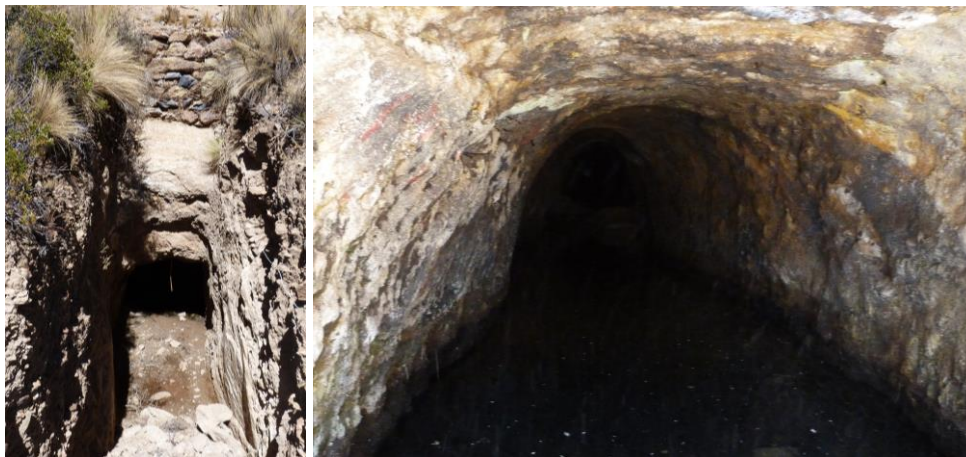
Figuras 4.23 y 4.24: Tercer socavón en Sector 2 de Fundiciones. Vista exterior e interior.
