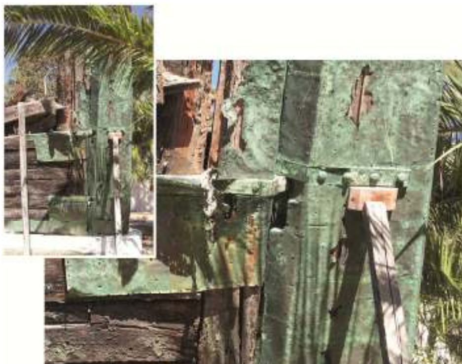
FIGURA 6.12 – CODASTE DE UNA FRAGATA ESPAÑOLA CON AFORRO DE COBRE.
