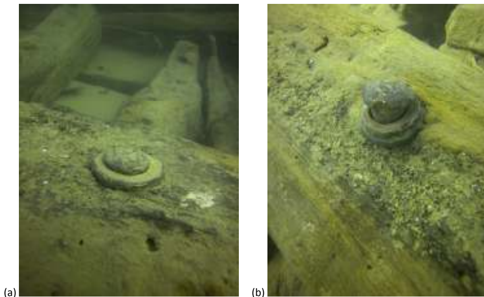
FIGURA A.10.4 – PERNOS REMACHADOS SOBRE ARANDELA.
