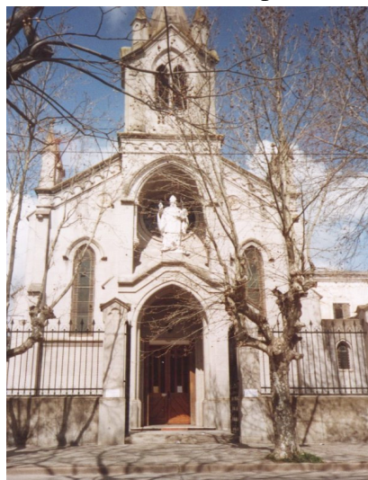
Iglesia San Patricio. San Antonio de Areco
