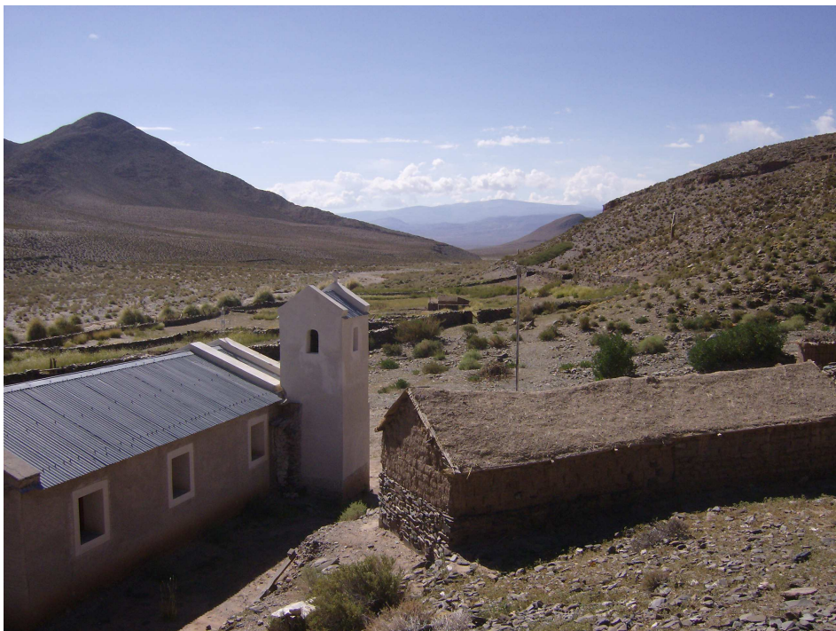
Figura 5.3: Detalle del sector de quebradas en el Valle de SAC, ilustrado a partir de la Quebrada de Matancillas, vista desde la ubicación de la capilla principal. Obsérvese el fondo de quebrada delimitado por la pendiente de los cerros.
