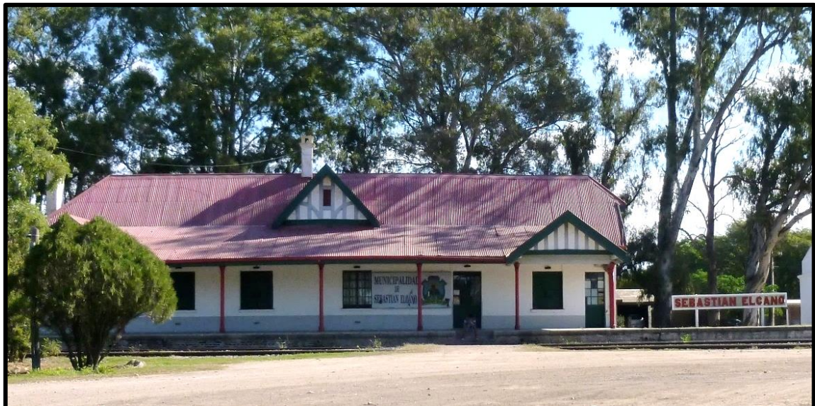
Figura 35. Estación de ferrocarril de Sebastián Elcano (actualmente sede municipal). Fuente: Fotografía tomada durante el trabajo de campo (2015).
