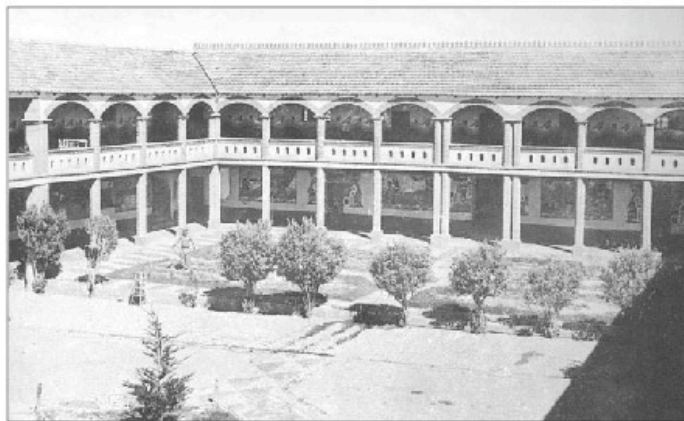
Patio del edificio central ya terminado. Fuente: Carlos Salazar Mostajo. Gesta y fotografía. Historia de Warisata en imágenes , Lazarsa, La Paz, 2005.
