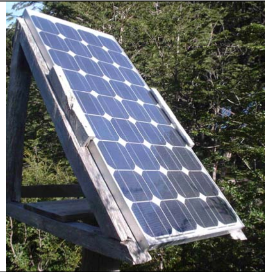
Foto 62. Panel solar para el abastecimiento de energía eléctrica del refugio
