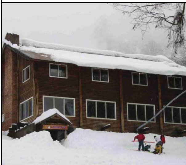
Foto 3. Refugio del cerro Perito Moreno, centro de esquí y deportes invernales
