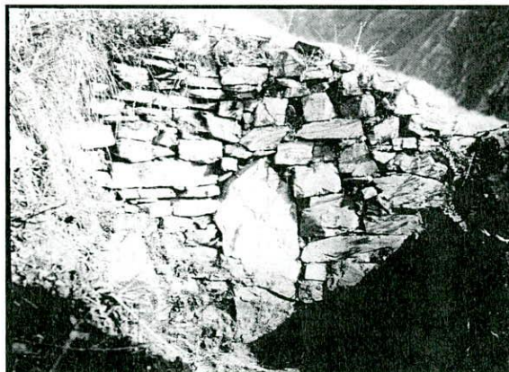
Foto 6.8 Detalle de construcción del muro en Huaira Huasi (Márquez Miranda 1937).
