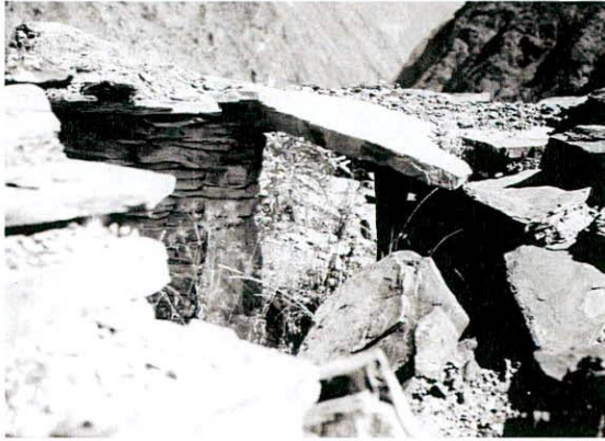
Foto 6.15 Revestimiento exterior de la techumbre en falsa bóveda en Titiconte (A.M.E.).
