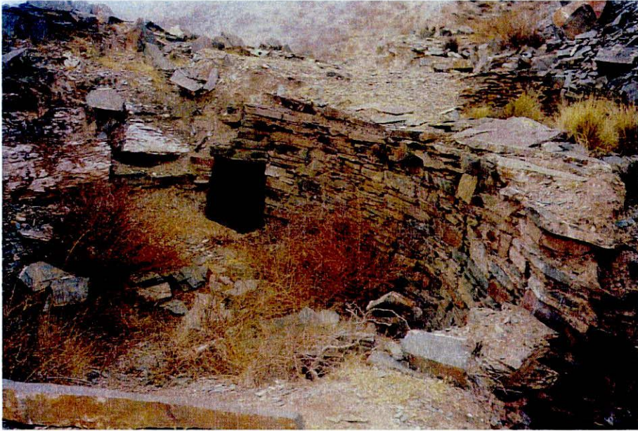
Fotos 6.22 y 6.24 Estado de conservación de los recintos en Titiconte. Fotografías actuales (Foto Ventura 2005).
