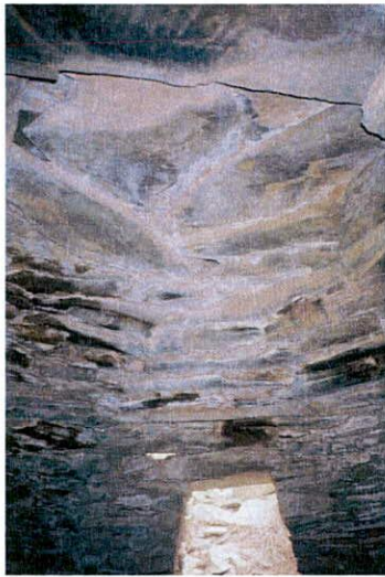
Foto 6.16 Interior de techumbre en falsa bóveda en Titiconte. (Foto Ventura 2005).
