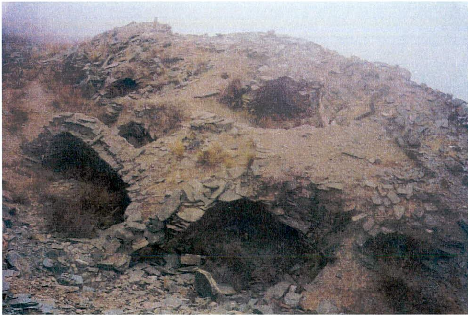
Foto 6.25 Derrumbes en Titiconte (Foto Ventura 2005).
