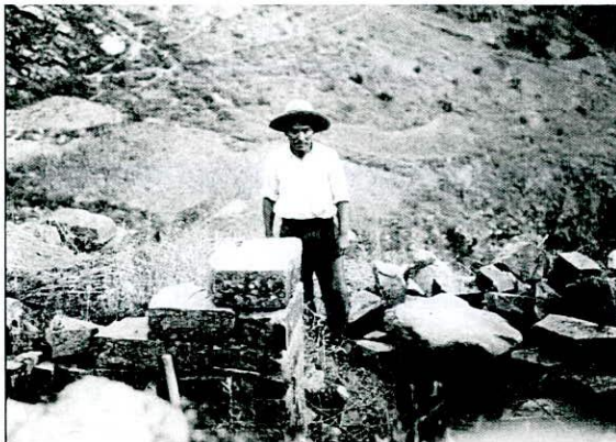
Foto 6.3 Presencia de canteo en Huaira Huasi, Márquez Miranda 1934-1938 (A.M.E.).
