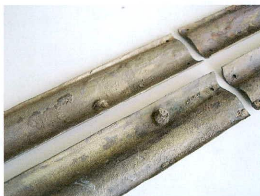
Figura 6.70 – Tornillos de fijación quebrados a la altura de la base (Foto: N. Ciarlo 2008).
